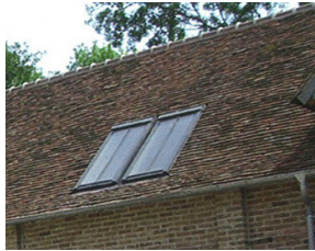
Plusieurs chassis classiques (type velux) peuvent être juxtaposés
