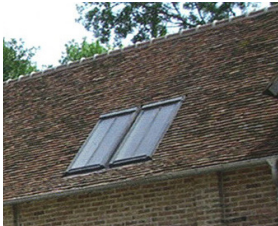
Plusieurs châssis classiques (type velux) peuvent être juxtaposés
