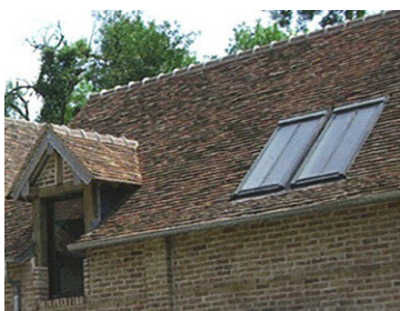
Juxtaposition de deux chassis ouvrants.
